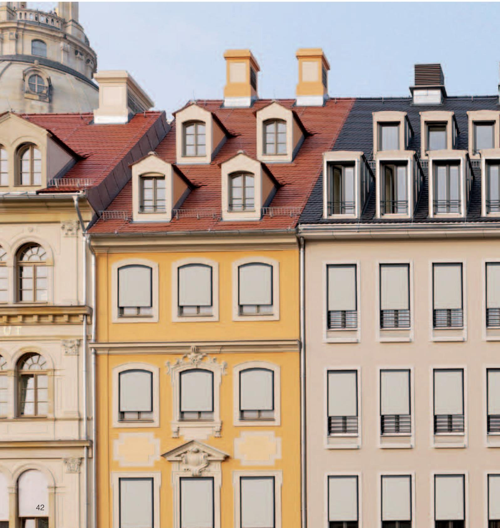
WAREMA Senkrecht-Markisen sind ein funktioneller Sonnenschutz für senkrechte Fensterfronten in Lochfassaden. Eine Kastenabdeckung schützt das Markisentuch vor Witterungseinflüssen. Kurbel- oder Motorantrieb und eine große Bandbreite an Abdeckungen repräsentieren eine komplexe Auswahl, die Freiräume schafft: für individuelle Planungen und Fassadenlösungen.
