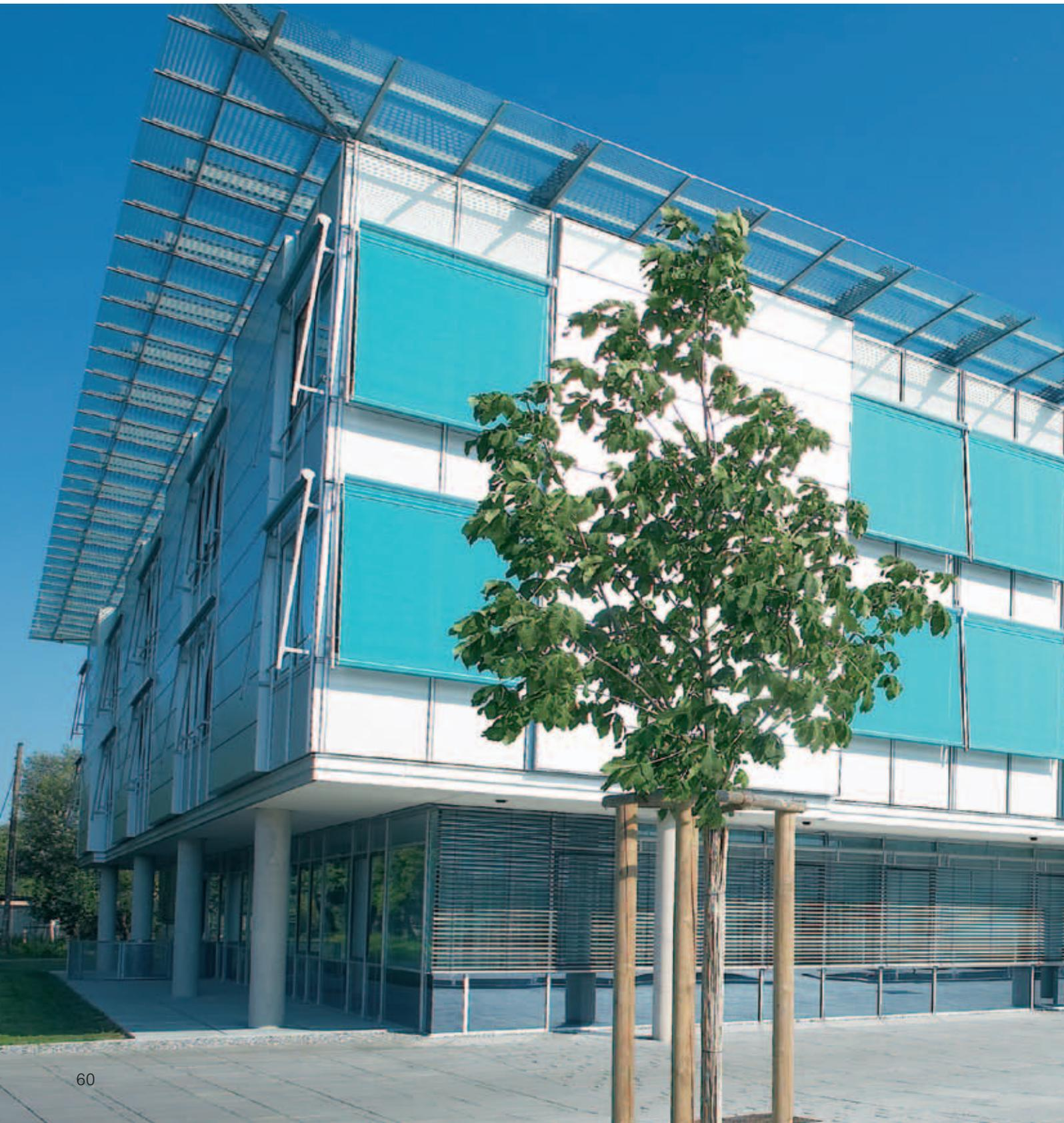
WAREMA Fassaden-Markisen sind für die Verschattung mehrgeschossiger Anlagen konzipiert und passen sich baulich dem vorgegebenen Fassadenverlauf an. Variationsmöglichkeiten von Blenden und seitlichen Führungen zeichnen sie technisch aus. Optisch überzeugen sie als gestaltendes Element der Gebäudefassade – möglich auch in Kombination mit Markisoletten.
