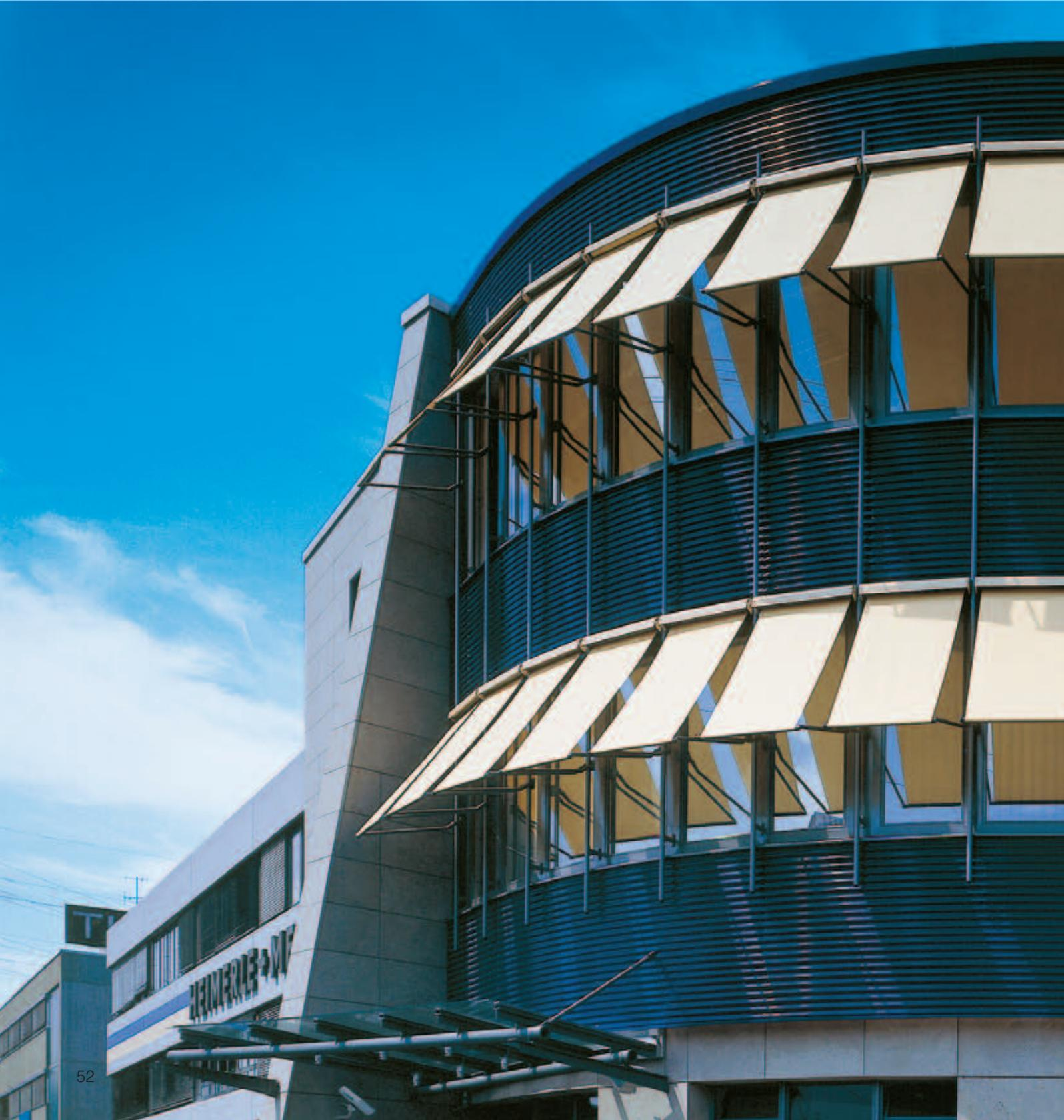
WAREMA Fallarm-Markisen kombinieren Sonnenschutz und Verschattungsanforderungen – geeignet für senkrechte Glasflächen und Fenster in Lochfassaden. In ausgefahrenem Zustand bleibt die freie Durchsicht nach draußen erhalten. Die Anbringung kann optional durch einfache Klemmung erfolgen. Fallarm-Markisen verleihen Einfamilienhäusern einen mediterranen Flair.
